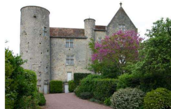
Figure 241 : Château de la Mothe (Source : Commune de Persac)
