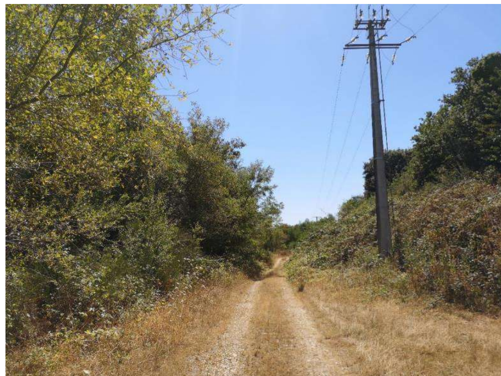
Figure 230 : Ligne HTA longeant le nord-est de l'aire d'étude immédiate Source : IDE Environnement, août 2020
