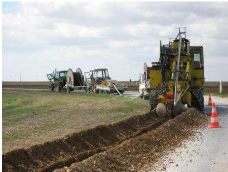
Figure 294 : Illustration des travaux de raccordement (source : EDF Renouvelables)
